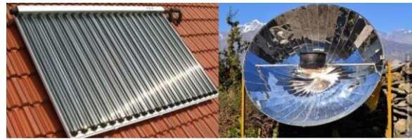
Abb.1: Solarthermieranlage mit Sonnenkollektor und ein Solarkocher.
