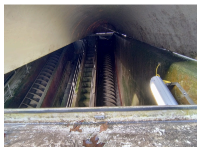
Blick ins Hebewerk mit archimedischer Schraube
